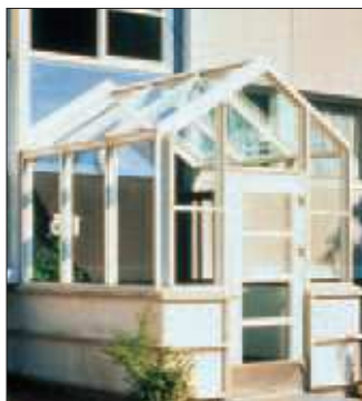
Esempi di verande utilizzate come protezione o tampone dell'ingresso per ridurre le dispersioni termiche.
